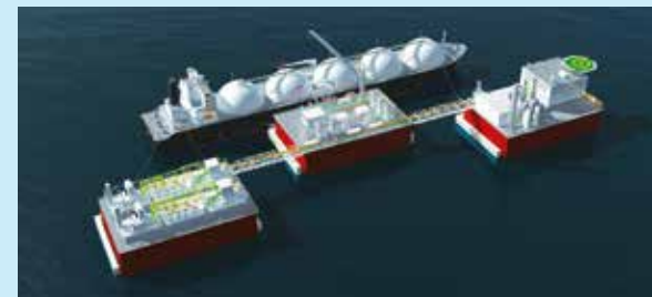
Gravifloat: Modularised LNG and LPG terminals
