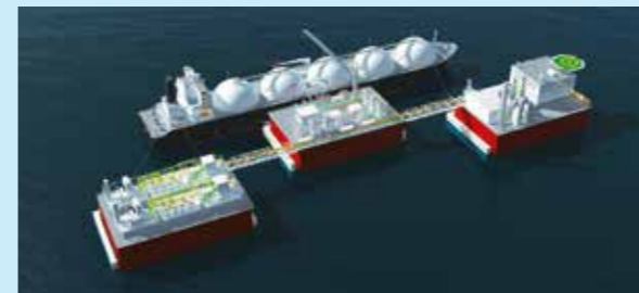
Gravifloat: Modularised LNG and LPG terminals
